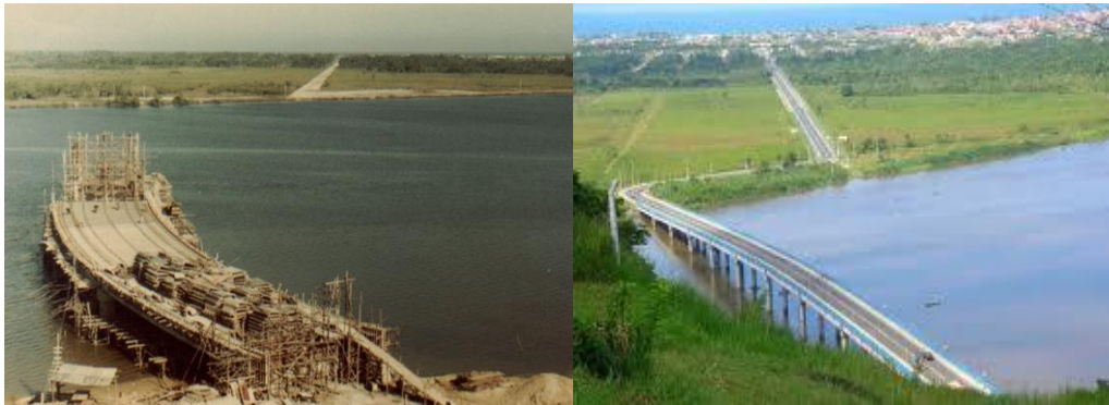
Figura 4: Construção da ponte interligando Iguape e Ilha Comprida e seu estado atualmente. Retirado de http://my.opera.com/perfeito/albums/showpic.dml?album=495402&picture=6840129
